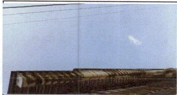
Foto 6: Sustrucción de canal de metal
