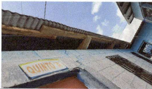
Foto 5: Sustrucción de canal de metal
