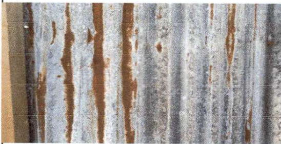
Foto 3: Sustrucción de lámina, por lámina troquelada aluzinc calibre 26
